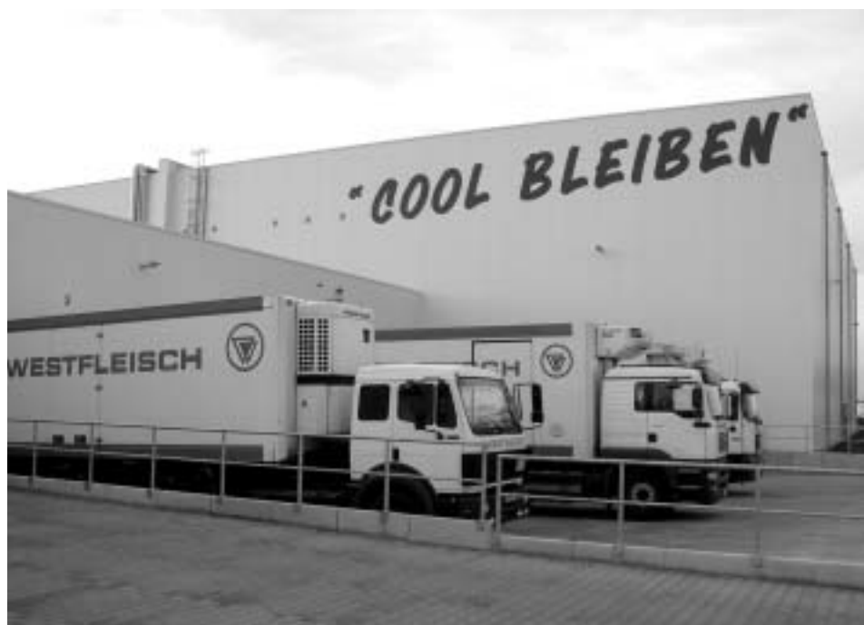
Vier Lkw gleichzeitig können an getrennten Andocktoren be- und entladen werden.
