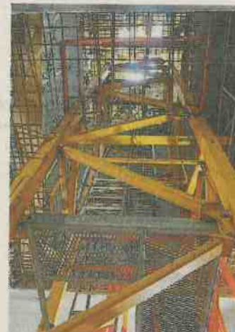
Um die schweren Bauteile sicher zu transportieren, wurde der Baukran im Gebäude verbaut.
